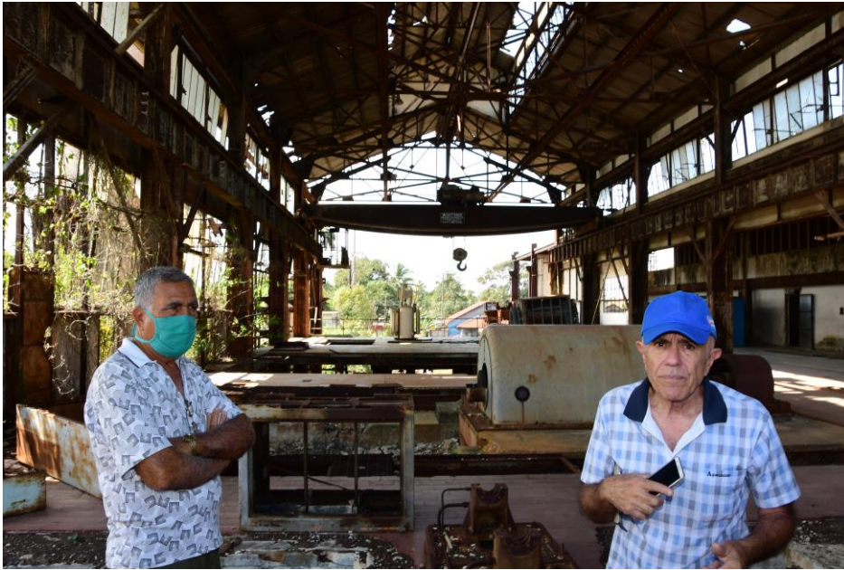
Illustration 6 : état du bâtiment abritant la sous-station de production d'énergie électrique pour l'alimentation électrique du réseau ferroviaire
