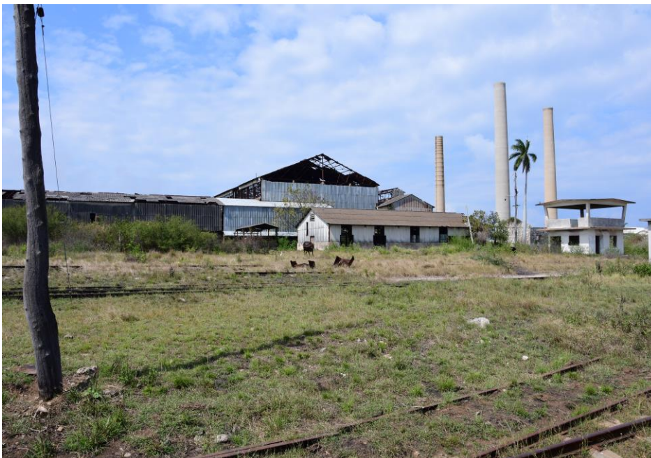
Illustration 7 : terrain attenant au dépôt-atelier de Hershey susceptible d'accueillir une centrale solaire
